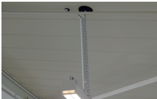
Leuchten von Decke abhängen
