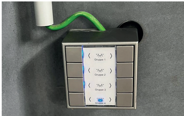
Befestigung von Schaltern und Bedienpanels
