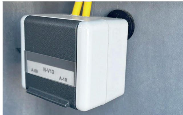
Steckdosen direkt am Stahlträger montieren
