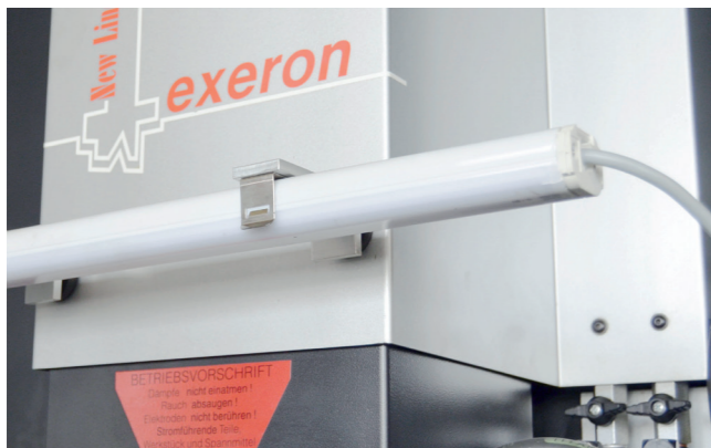
Beleuchtung direkt an Maschinen befestigen
