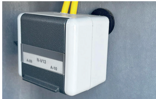
Steckdosen direkt am Stahlträger montieren
