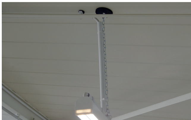
Leuchten von Decke abhängen
