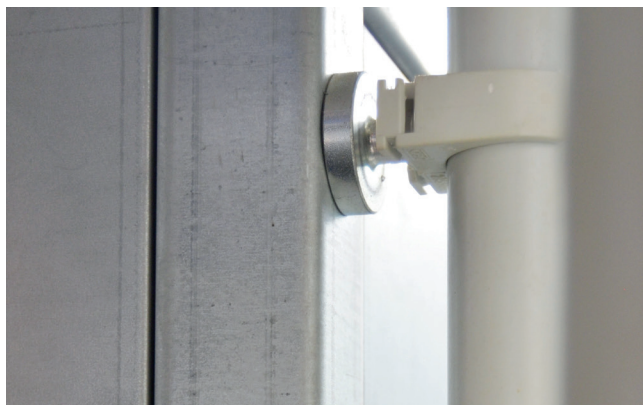
Kabelkanäle magnetisch befestigen
