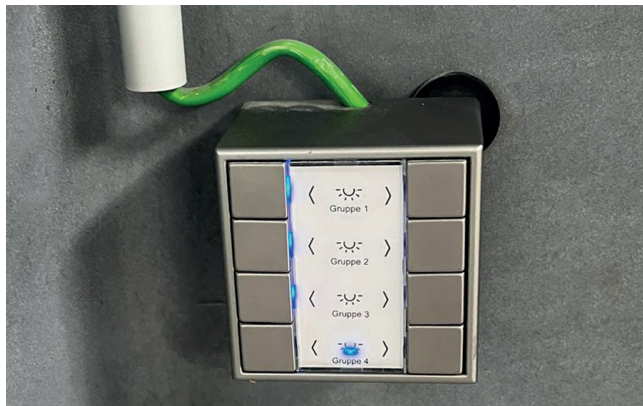
Befestigung von Schaltern und Bedienpanels
